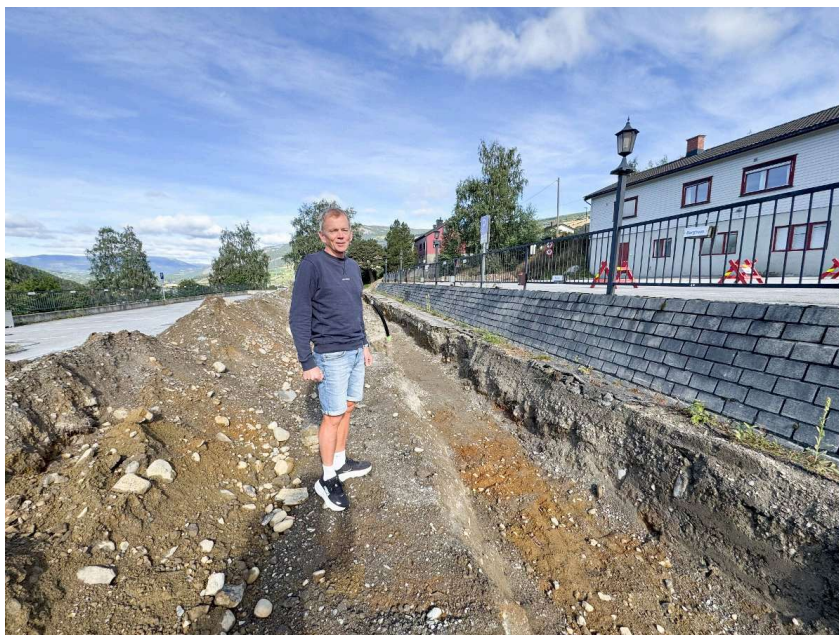
- Vi skal være ferdige med det meste til 1. desember. Det gamle prestehuset (til høyre i bildet) skal også rives, sier Bergum. Foto: Kristin Roset
