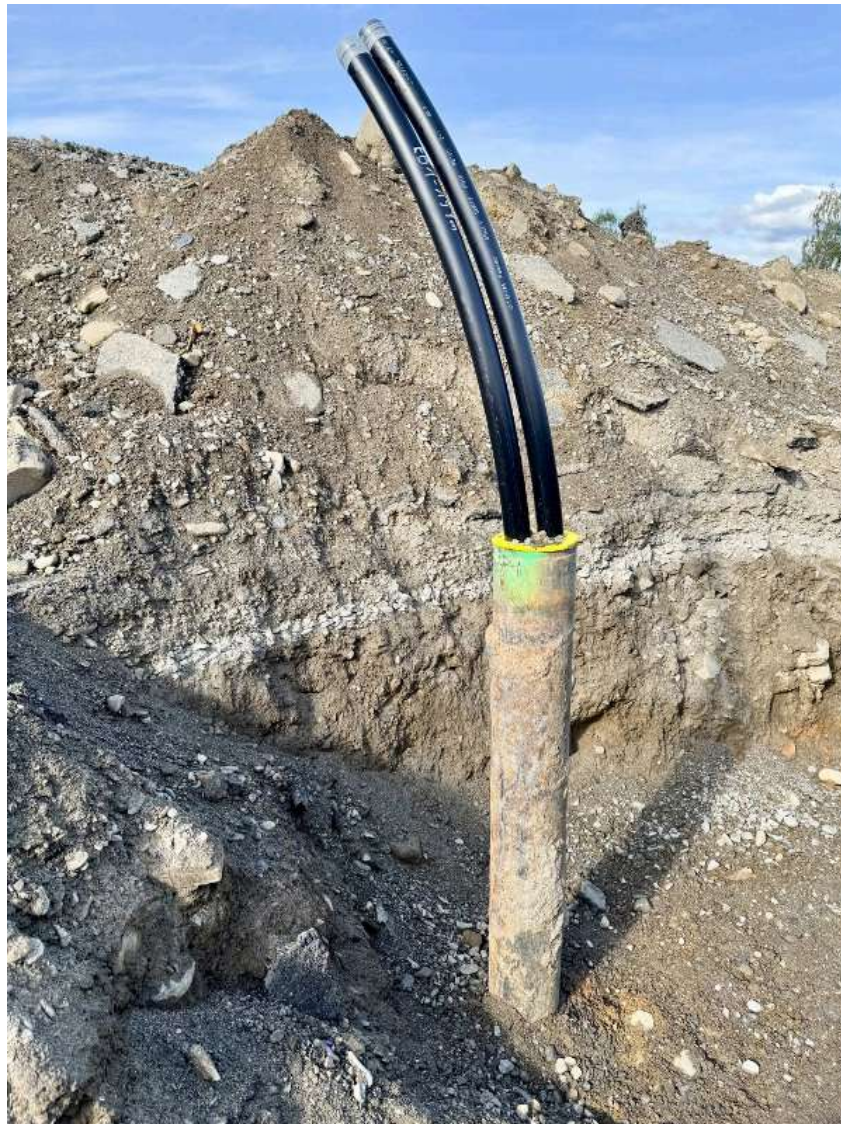
Et av de fjorten hullene som er boret ned til 200 meters dybde. Foto: Kristin Roset
